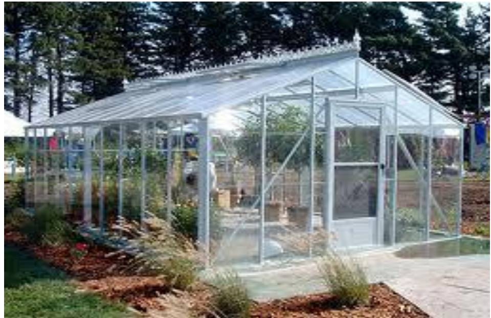
Gambar 1 Contoh Bangunan Rumah Bibit
